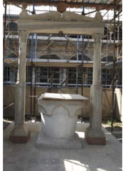
Lavori di ristrutturazione dei chiostri danteschi
