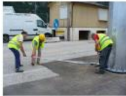
Controllo e regolazione verticalità, serraggio bulloni con chiave dinamometrica.
