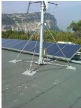
Basamento con puntoni H3m con antivibranti.
