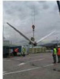
Assemblaggio della navicella e montaggio a terra delle pale 1 e 2.
