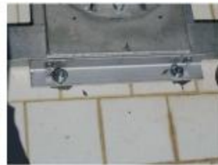
Fissaggio mediante tassellatura con resina bicomponente.
