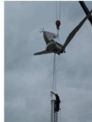
Assemblaggio della navicella e montaggio a terra delle pale 1 e 2.
