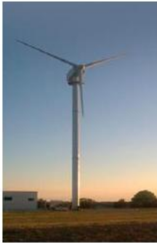
200 kw – diametro 28 m
