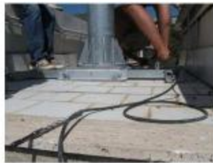
Fissaggio mediante tassellatura con resina bicomponente.
