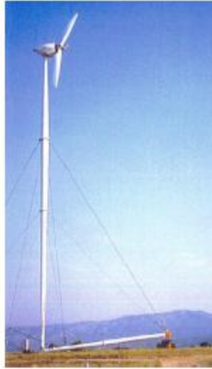
200 kw – diametro 32 m
