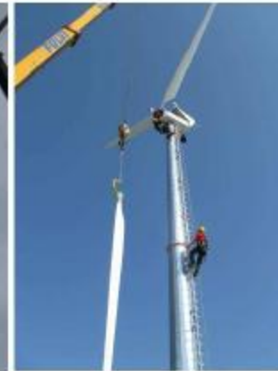
Montaggio navicella e pala 3
