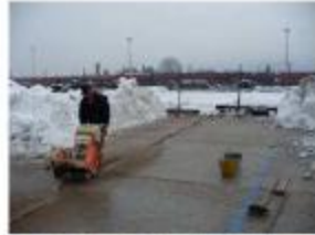
Taglio della pavimentazione
