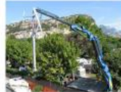
Sollevamento e posizionamento del rotore VAWT mediante camion gru.
